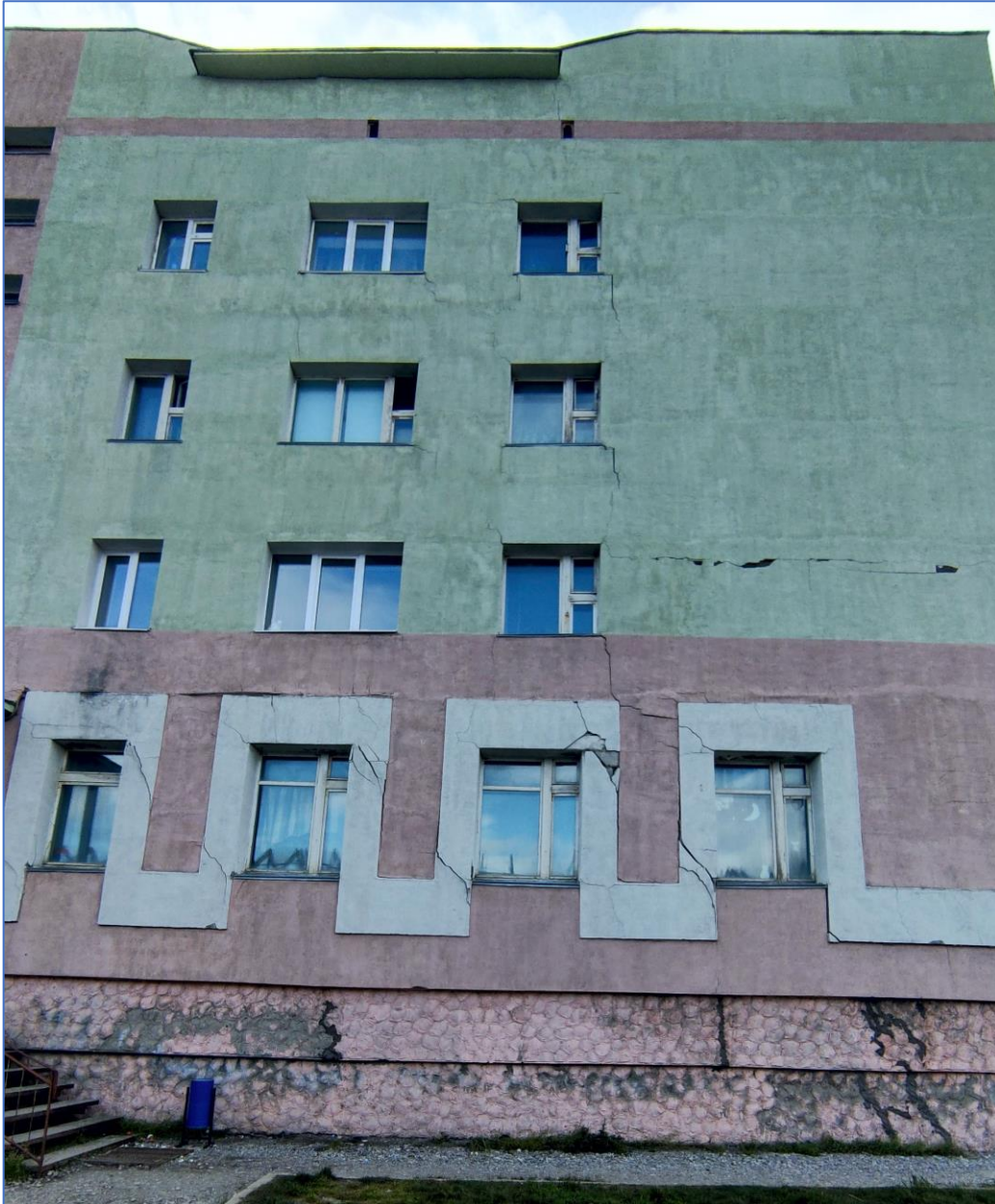
Трещины в стене дома №6 по ул. Дежнёва, с. Лаврентия, Чукотский АО
